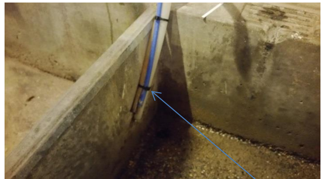
No air gap
